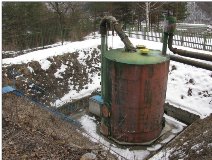
Фигура Бърз пясъчен самопромиващ се филтър
