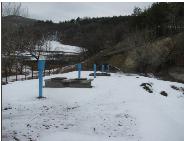
Фигура Хоризонтален утаител
