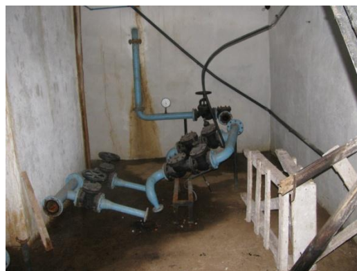
Фигура 3-24 Промивни помпи и бавен филтър
