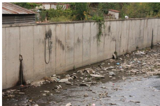
Фигура 3-31 Заустване на канал в р.Яденица и нарушена корекция на реката
