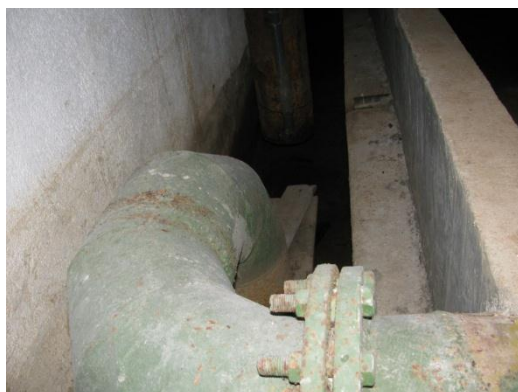
Фигура 3-23 Филтратата се извежда извън станцията, но не се пречиства бщ вид на хлораторно
