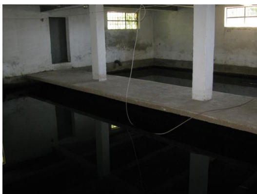
Фигура 3-13 Общ вид на хлораторно и бавен филтър
