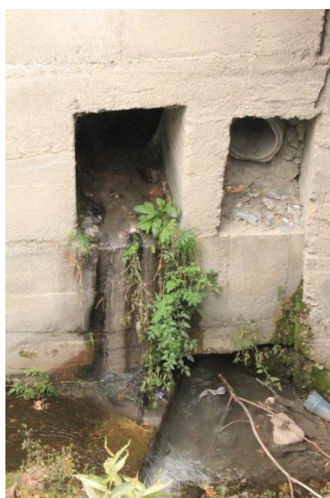
Фигура 3-28 Заустване на канал в р.Яденица
