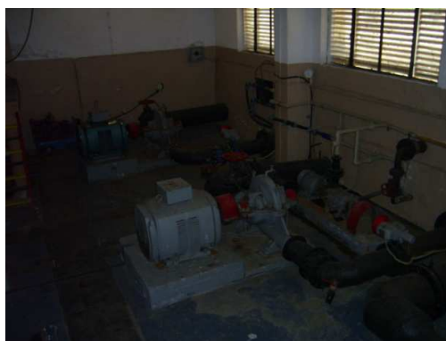
Фигура : ПС „Мокрище” – II подем – помпи нисък напор
