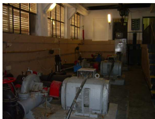
Фигура : ПС „Мокрище” – II подем – помпи висок напор
